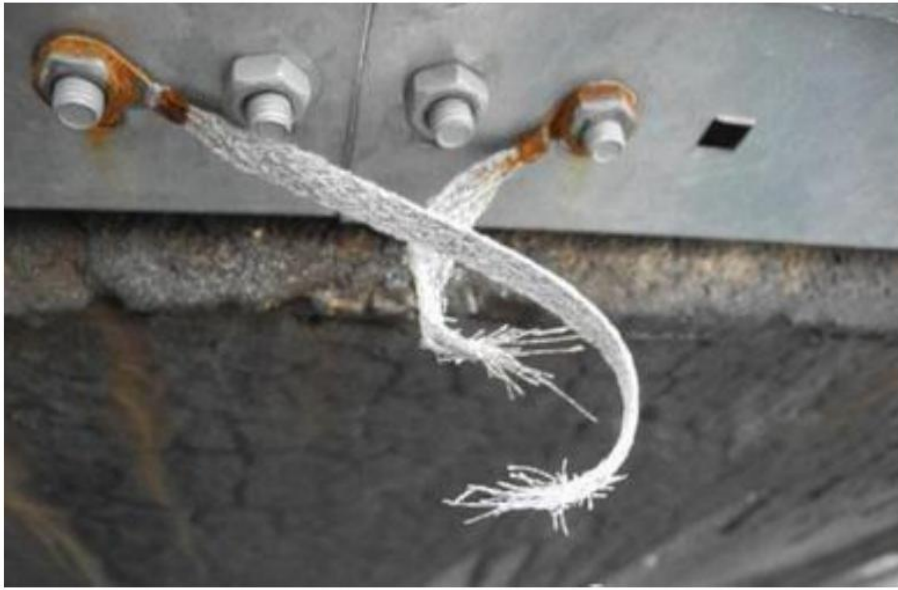
图 1-14 汇流箱接地虚接或老化
