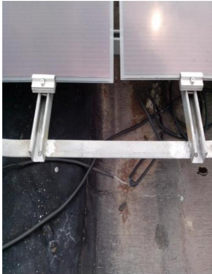
图 2-5 电缆不走桥架，无任何保护
