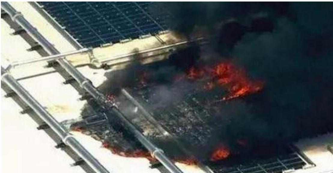
图 4-1 苹果公司工厂屋顶太阳能组件火灾
