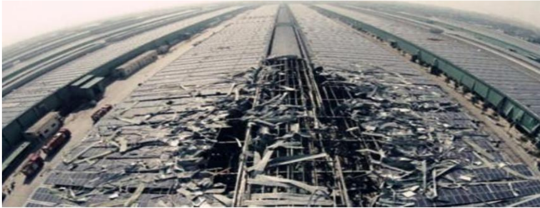
图 4-2 富华机械屋顶组件爆炸
