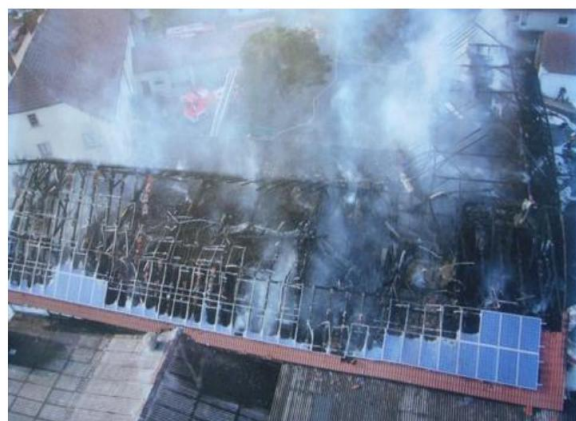
图 1-5 某电站组件自燃引起的火灾
